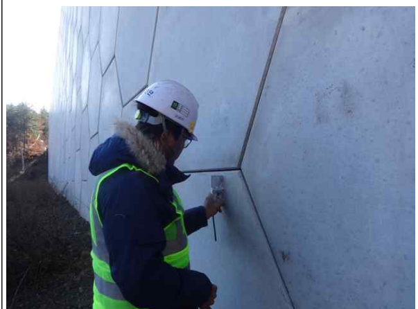
경사계를 이용한 경사도 측정
