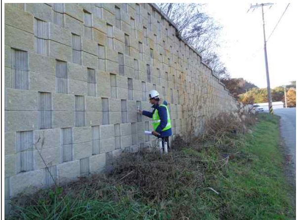
경사계를 이용한 경사도 측정
