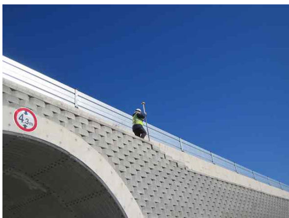
GPS측량기를 이용한 측량 작업
