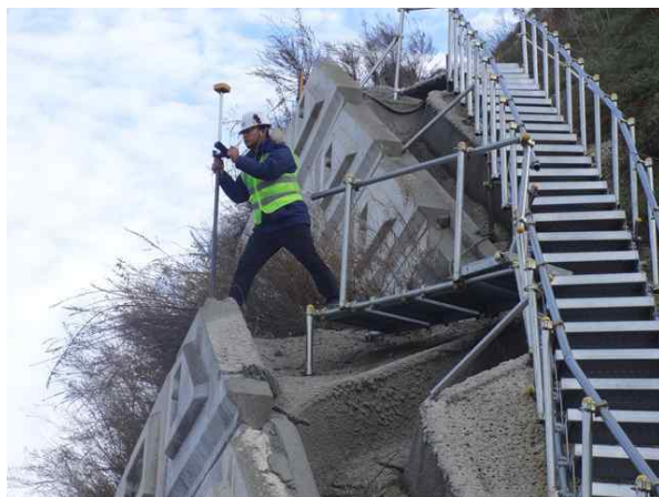
GPS측량기를 이용한 측량 작업
