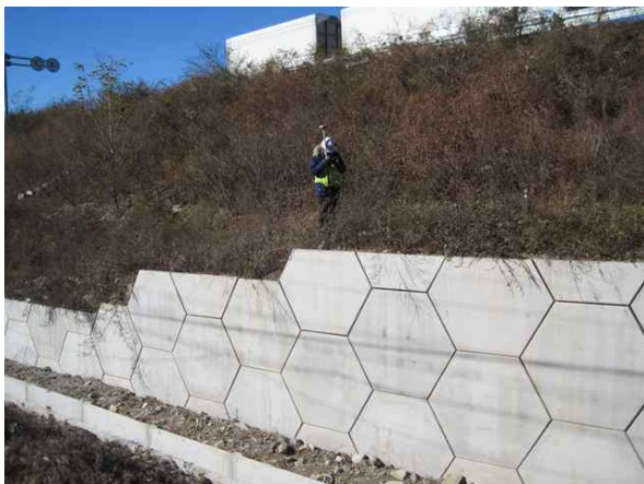
GPS측량기를 이용한 측량 작업
