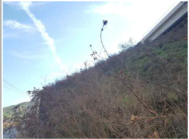
상부 성토부 전경
