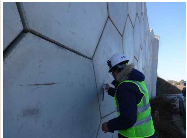
경사계를 이용한 경사도 측정
