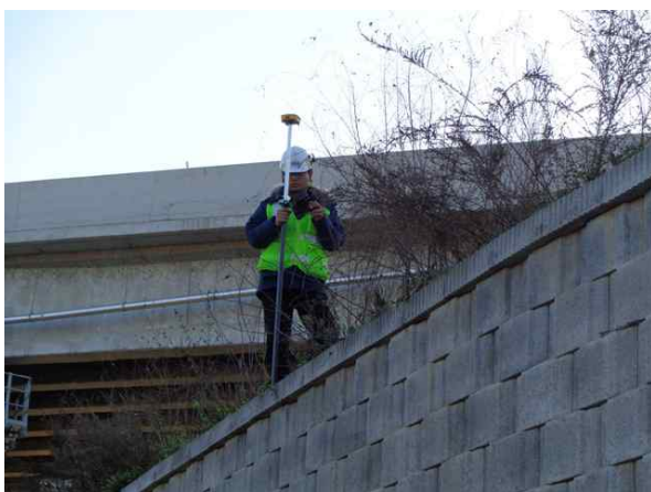
GPS측량기를 이용한 측량 작업
