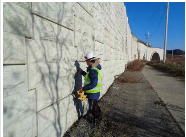
경사계를 이용한 경사도 측정
