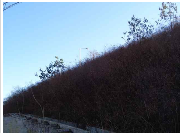
상부 성토부 전경
