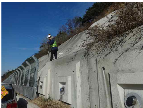
GPS측량기를 이용한 측량 작업
