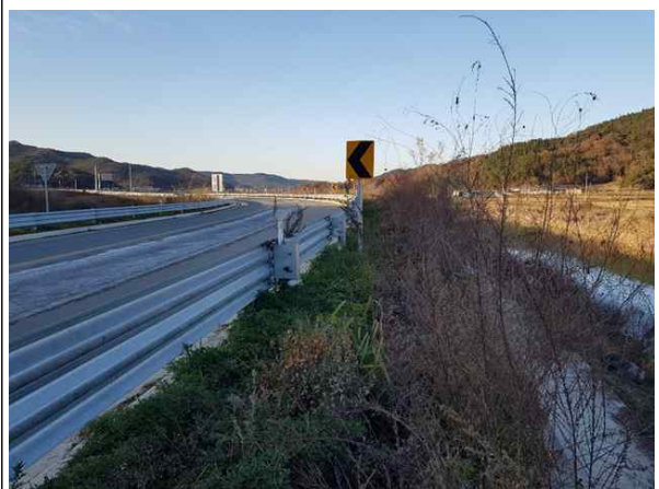
상부 성토부 전경
