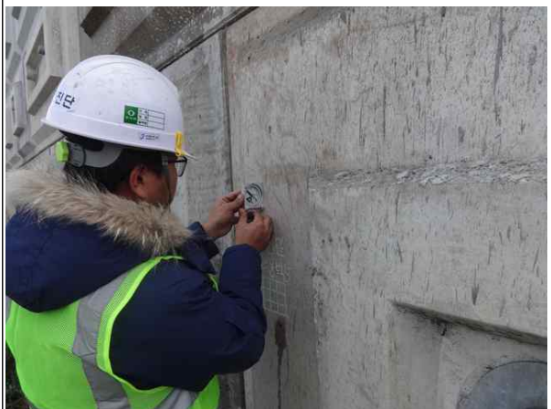
경사계를 이용한 경사도 측정
