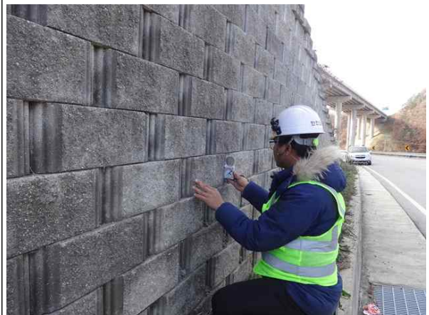
경사계를 이용한 경사도 측정
