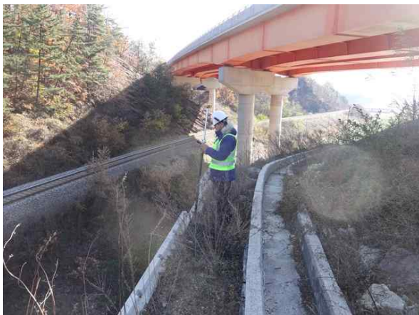
GPS측량기를 이용한 측량 작업
