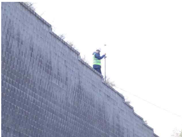
GPS측량기를 이용한 측량 작업
