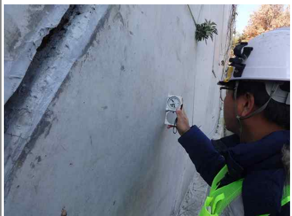
경사계를 이용한 경사도 측정
