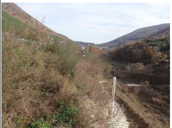
상부 성토부 전경
