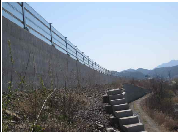
상부 성토부 전경
